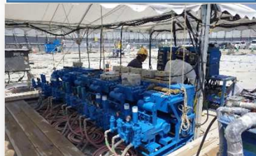
材料を地面に送るポンプ(高圧で送ります)
