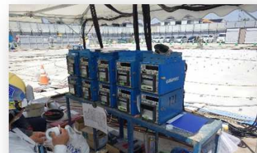
材料の注入量を記録する計器
