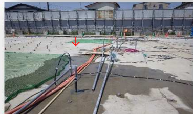
材料を注入している様子
