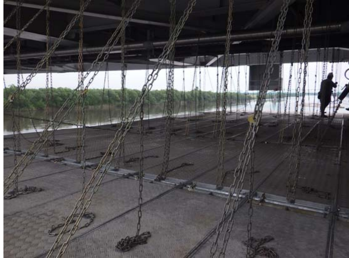
SKパネル組立状況
