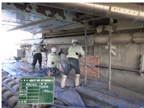
充電式空調服を使用して作業
