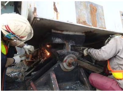
既存支承撤去状況
