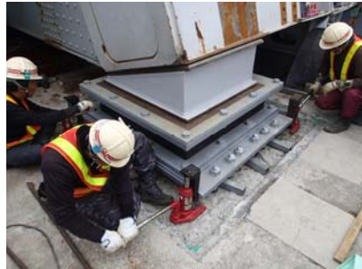
支承設置状況
