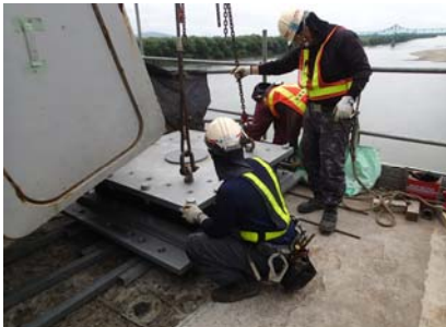
支承設置状況
