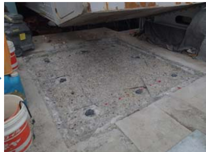
支承撤去完了
