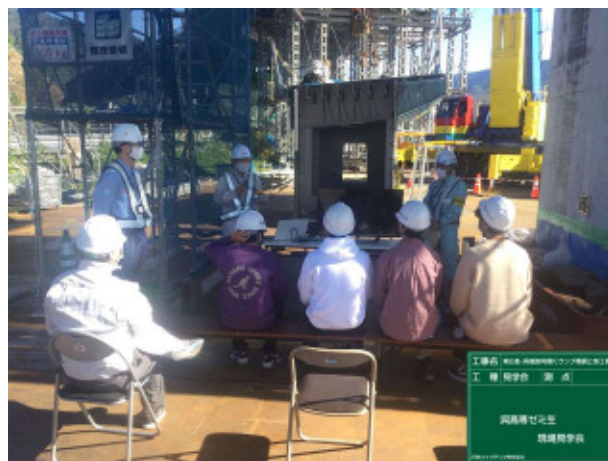
各工事概要説明
