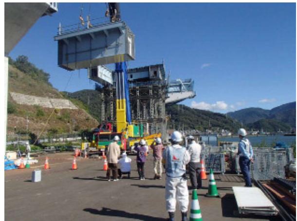
大型クレーンの橋桁架設状況視察
