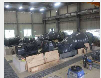
ポンプ据付完了
