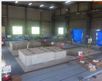
ポンプ据付前
