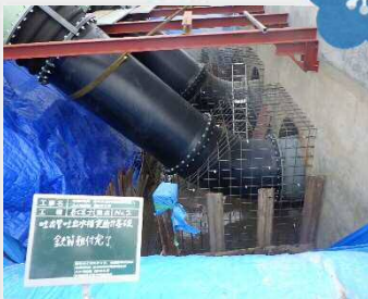
外部配管鉄筋組付
