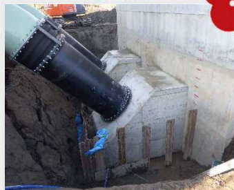
外部配管基礎据付
