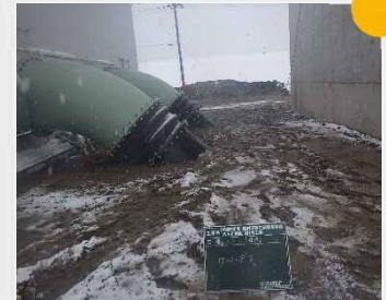
外部配管埋戻し完了
