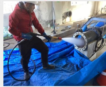
既存配管の洗浄作業
