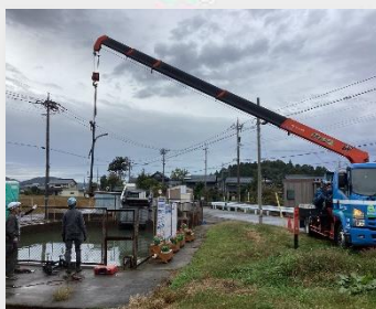
クレーン作業
