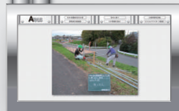
○工事現場写真アルバム
