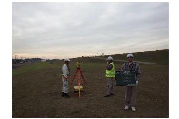
起工測量(レーザースキャナ撮影)
