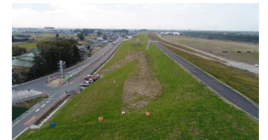
着工前：下流より
