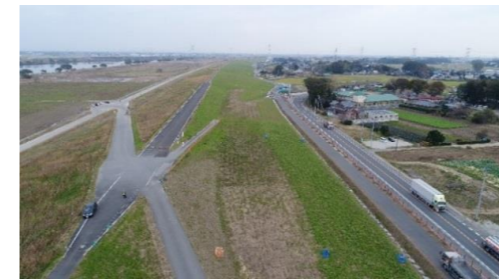
着工前：上流より
