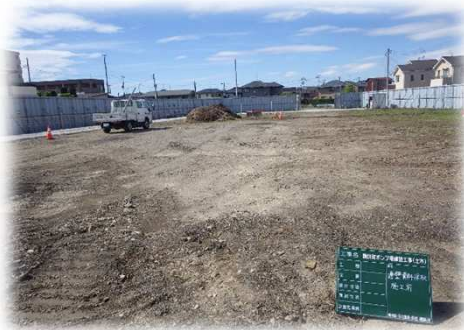
H29.6 建設予定地へ乗り込んだ頃。草刈から工事が始まりました。
