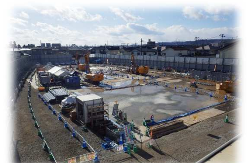
H30.11~ 薬液注入工の施工状況です。(現在施工中)
