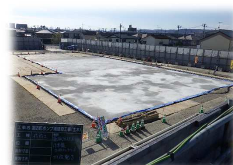
H30.11 左記の地中連続壁工事が終わり、現在施工している薬液注入工が、作業しやすい環境で能率が上がるように、場内を整備しました。
