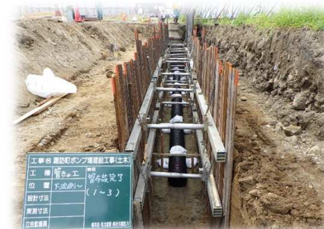
H29.7~10 敷地内に元々あった雨水管をポンプ場の建設に影響のない場所へ移設しました。土留をしながら掘削し、新しい雨水管を布設し埋め戻しました。
