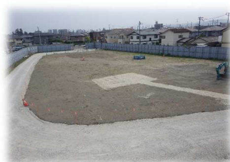
H29.6 敷地内に工事用道路を設置し、工事現場らしくなりました。
