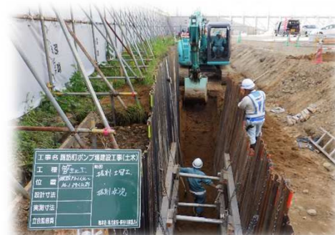
H29.7~10 敷地内に元々あった雨水管をポンプ場の建設に影響のない場所へ移設しました。土留をしながら掘削し、新しい雨水管を布設し埋め戻しました。
