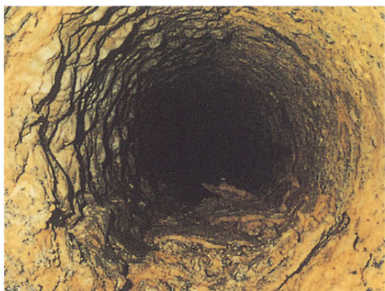
施工前 (経年铸铁管)
